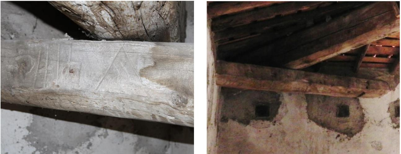
**Fig. 7.** Dettagli della struttura lignea di copertura: a sinistra marcatura mercantile della trave eseguita per certificare la proprietà del legname, a destra elemento conservante tracce del suo trasporto come parte di una zattera durante la fluitazione (foto E. Zamperini).
