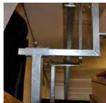
Il **parapetto laterale** è una protezione anticaduta semplice e veloce sia per il montaggio che per lo smontaggio. Il prodotto è interamente in acciaio zincato ed è certificato secondo la normativa europea UNI EN 13374 classe A.
